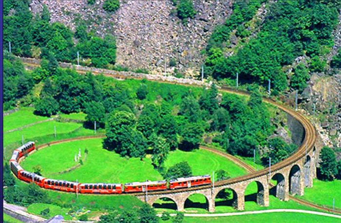
Ferrovia del Bernina, viadotto elicoidale.
