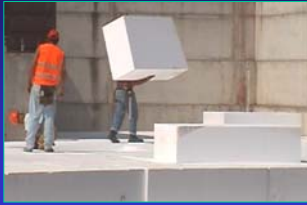
Messa in opera dei blocchi
