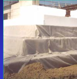
Ricoprimento con geosintetico
