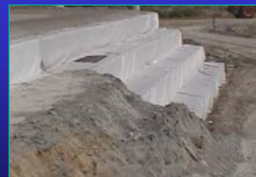
Ricoprimento con top soil
