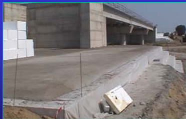
Soletta e ancoraggi verticali
